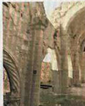
Le strutture della chiesa di Martis
